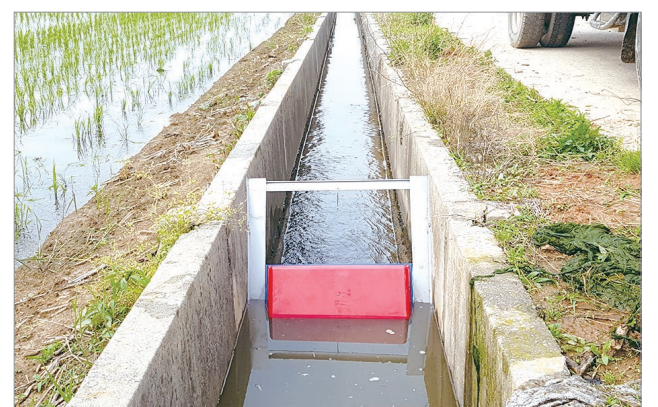
부력식 자동제수문을 설치하면 기존 급수량의 70%씩만 내려줘도 저수지 끝에 가까운 논에도 물이 공급될 수 있다.
